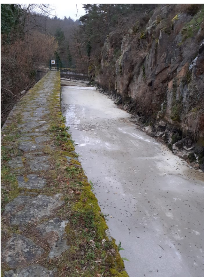
Dalle dans les murs
