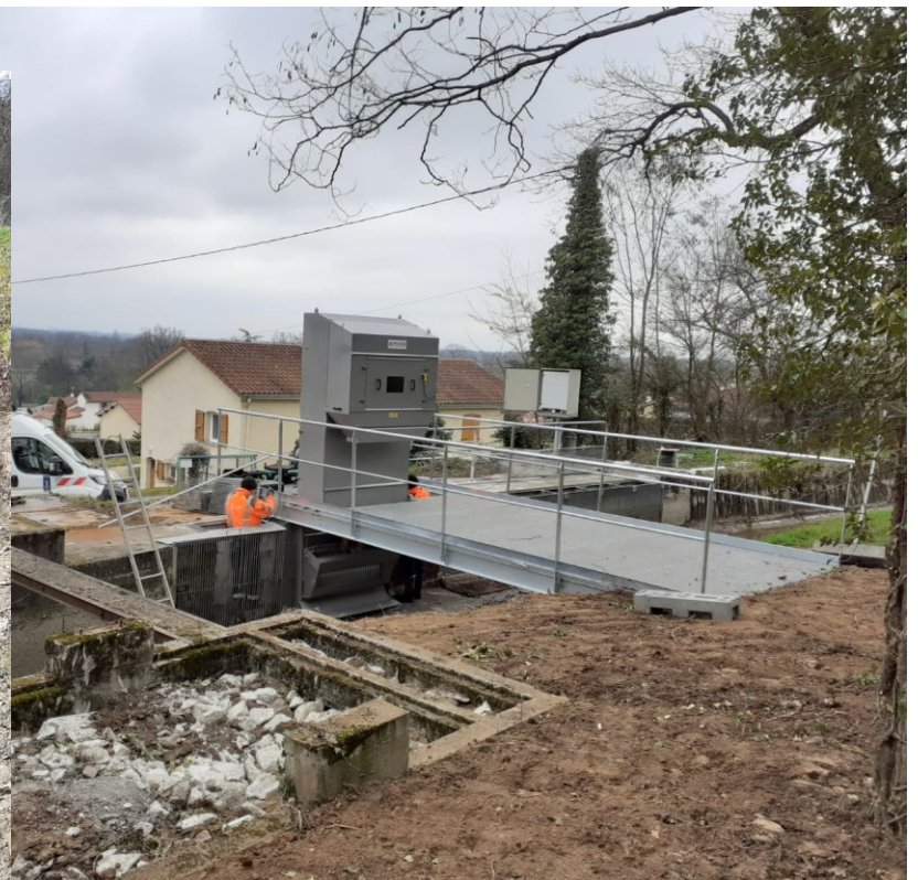
Pose d'un dégrilleur
