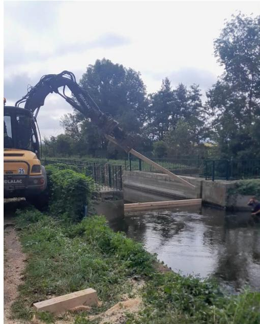
*Mise en place des batardeaux sur le PC Ozon*
