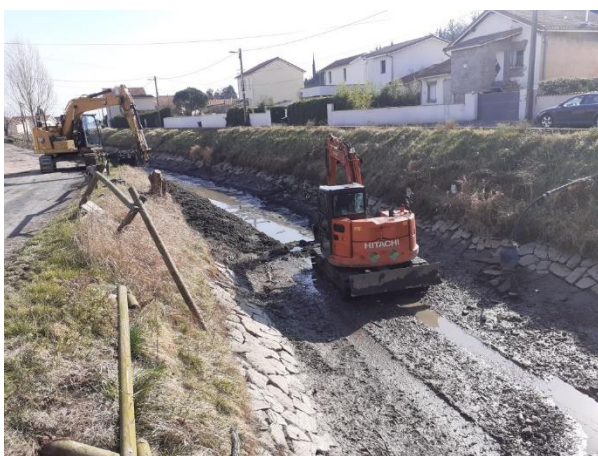
Curage Branche Principale du Canal à ST ROMAIN LE PUY
